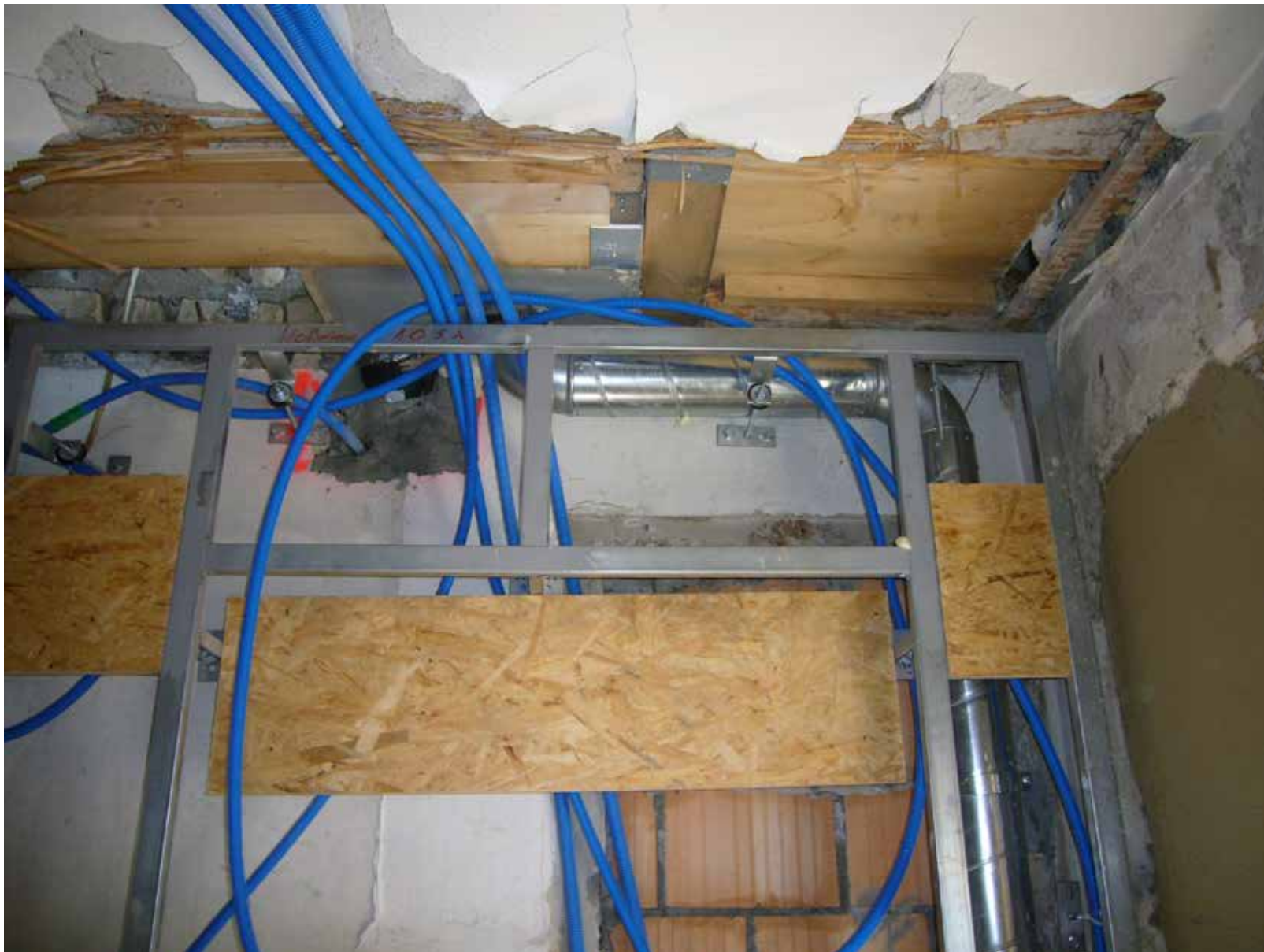
neue Elektroinstallationen Bad
