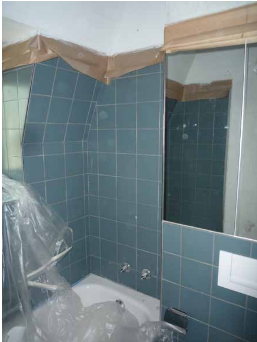
Malerarbeiten im Bad
