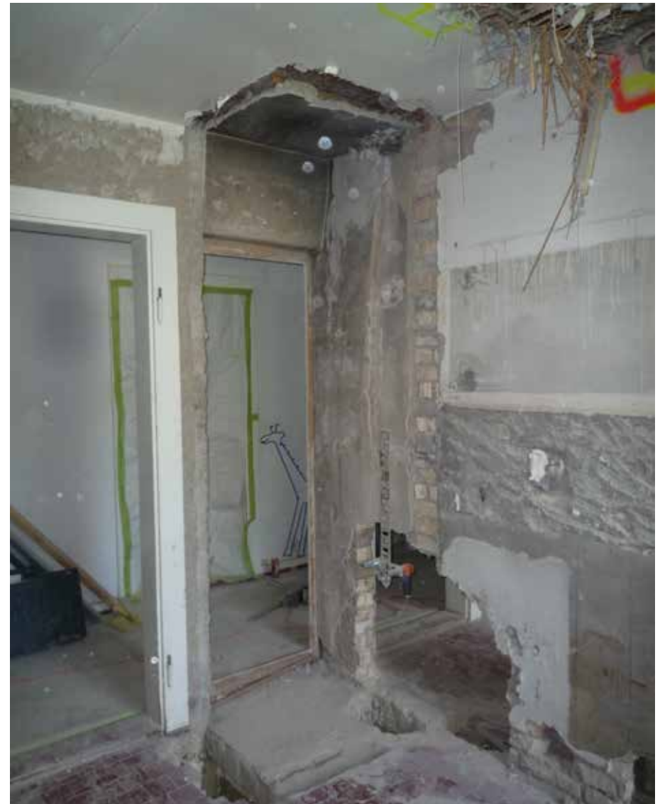
Spitzarbeiten für neue Haustechnik
