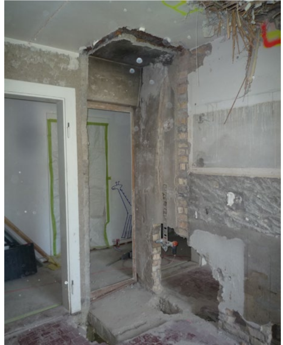
Spitzarbeiten für neue Haustechnik
