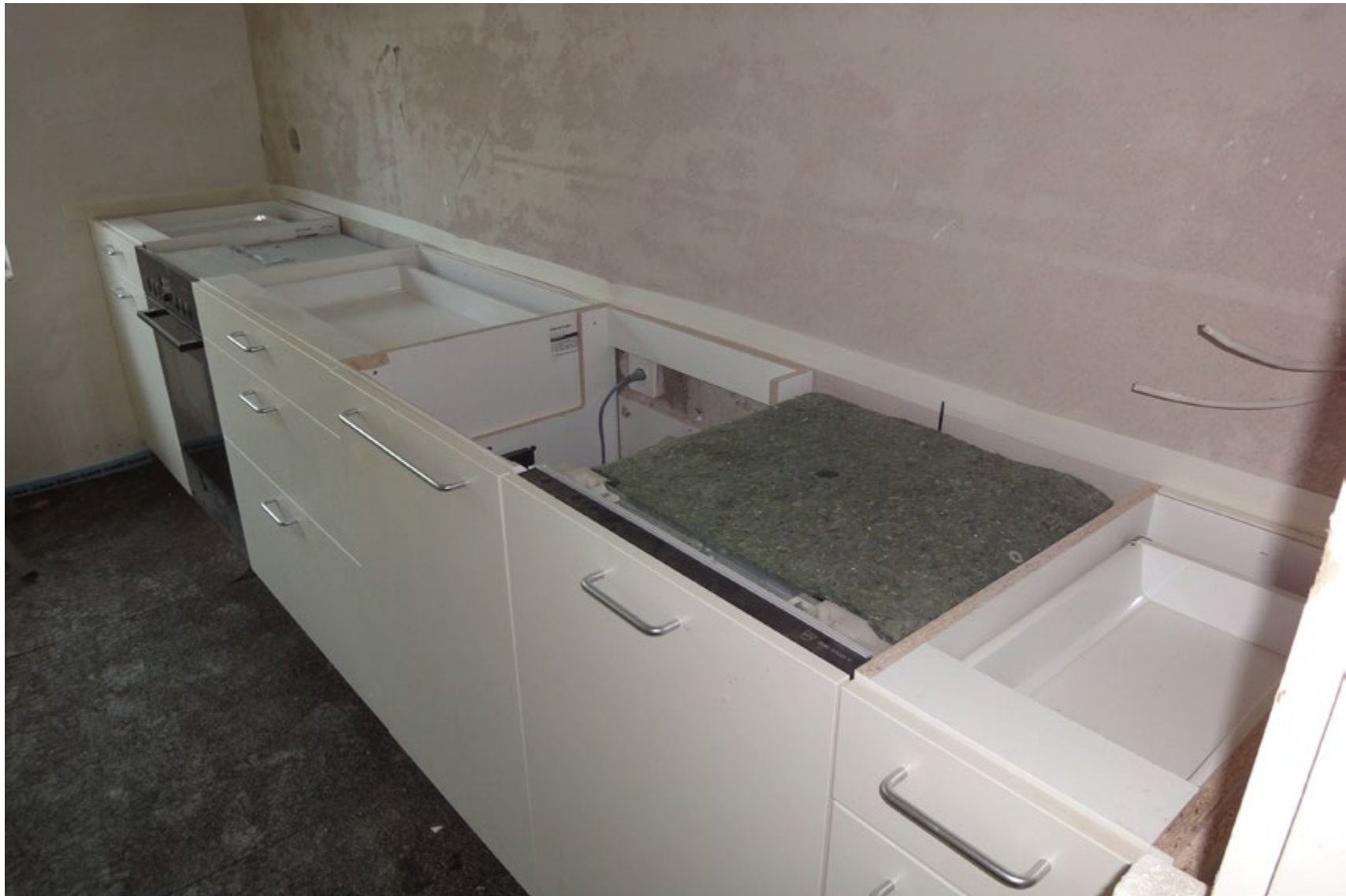
Einbau Küche (Referenzbild, entspricht nicht dem Projekt)
