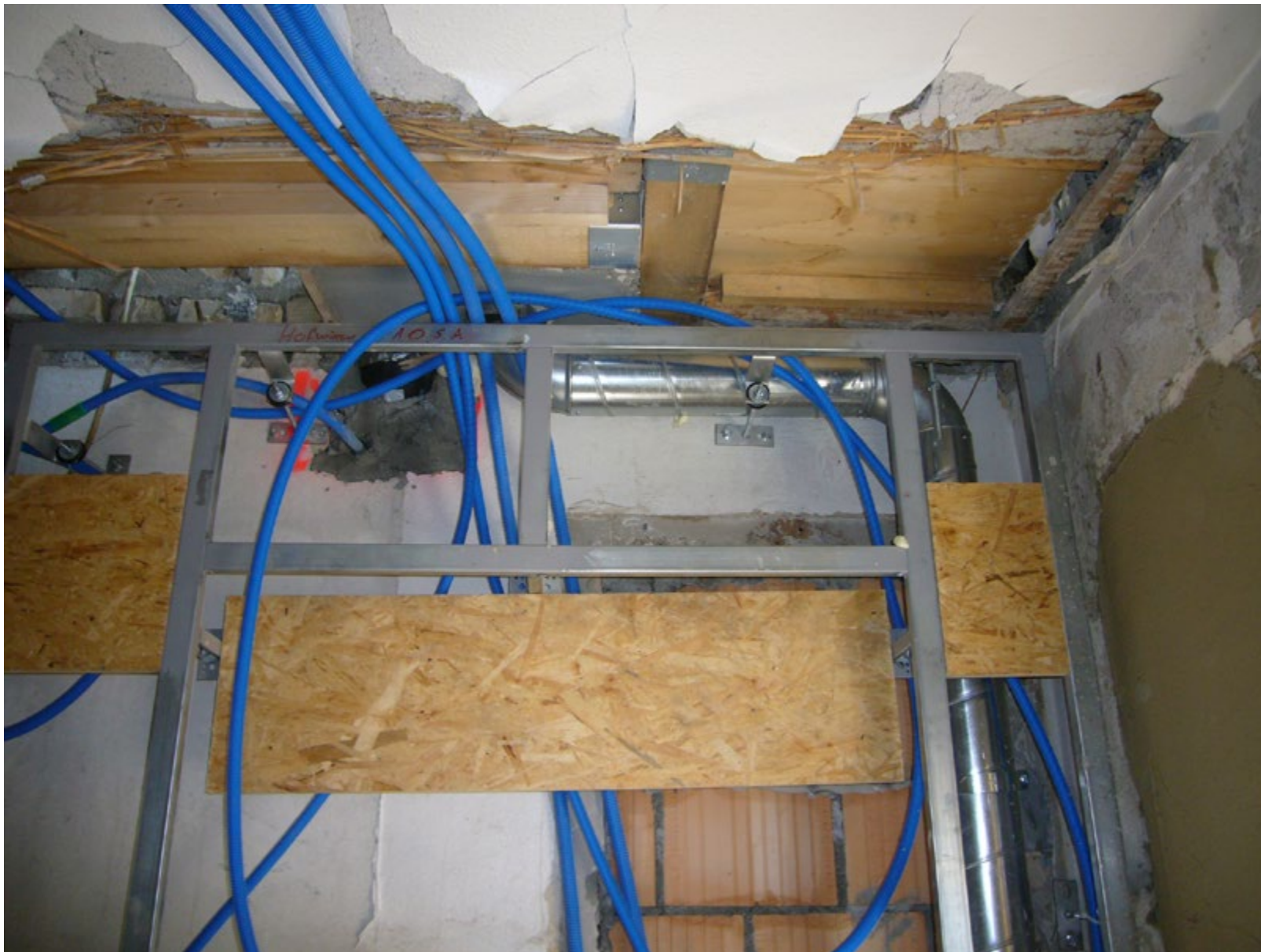
neue Elektroinstallationen Bad
