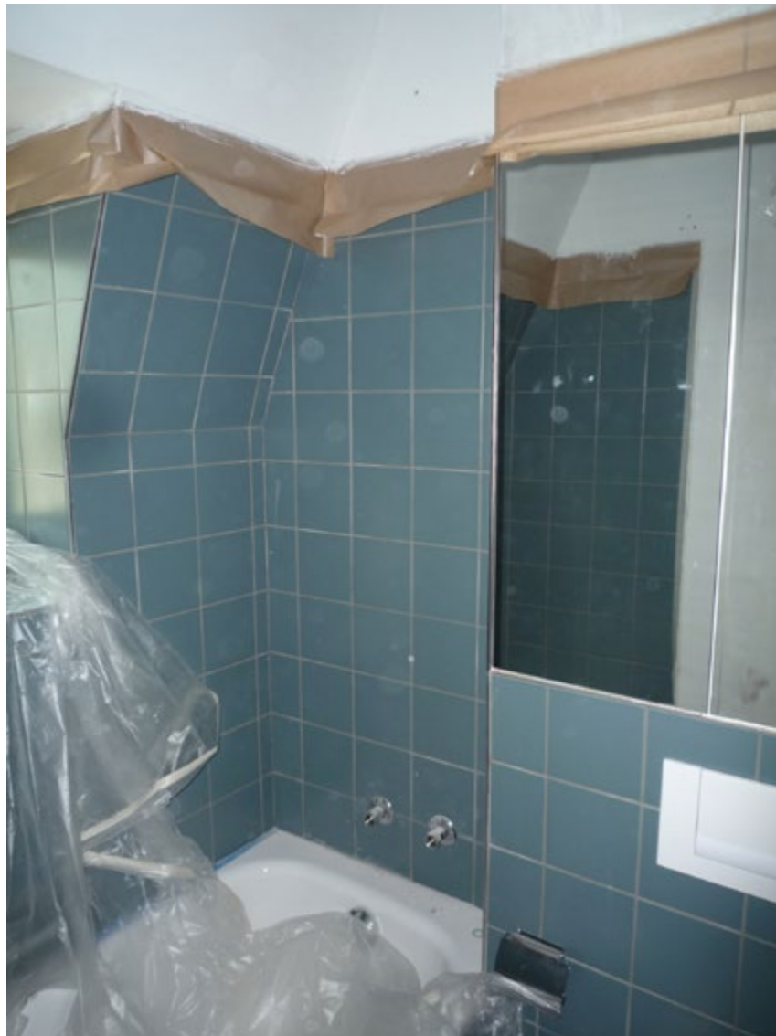
Malerarbeiten im Bad (Referenzbild, entspricht nicht dem Projekt)
